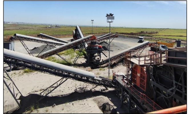
Şekil 1. Bazalt agrega tesisleri
