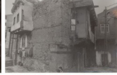
Foto. 29: Ali Paşa Mah Camii Sokak No 20 (H.Karpuz)
