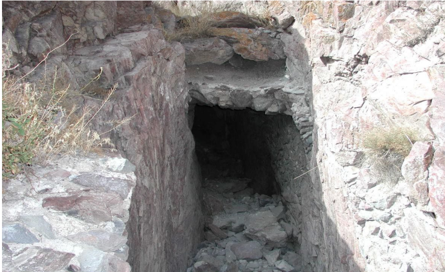
Resim 10: Pasinler Kalesi Kaya Basamaklı Su Tüneli Girişi
