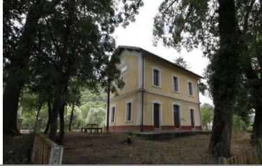
4. Çukurbük Gar Binası
