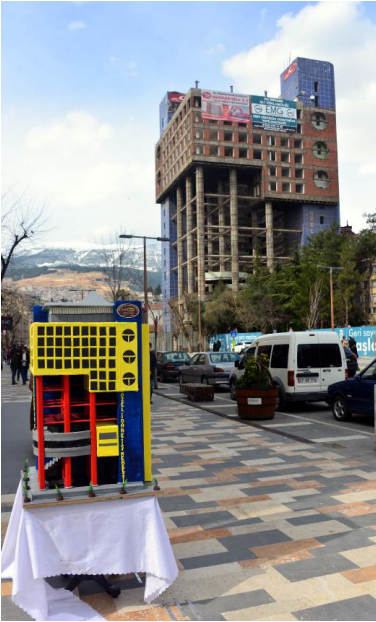
Şekil 6: Pastasıyla beraber Sarı Bina. Tele1, 4 Eylül 2020. https://tele1.com.tr/kahramanmarastadunyanin-en-sacma-binasi-yikiliyor-217212/ .
