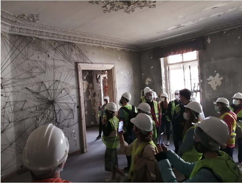
Şekil 4: Casa Botter restorasyonundan bir fotoğraf. İBB Miras, https://miras.ibb.istanbul/santiye-gezileri/casa-botter/ .
