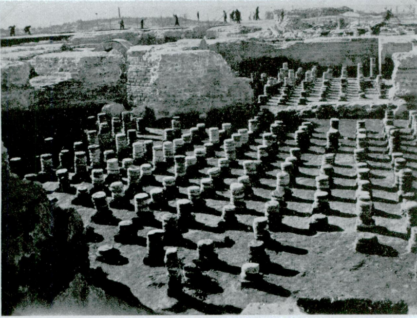
Döşemeyi taşıyan mesnet direkleri. «Yuvarlak tuğlalar»
