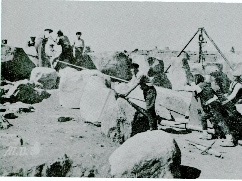
Sfenkli kapının restorasyonu
