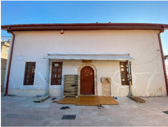
Fotoğraf 17: Harim giriş cephesi (Özkan, 2023)
