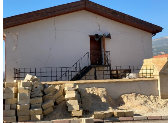
Fotoğraf 14: Cami doğu duvarına eklenen giriş (Özkan, 2023)
