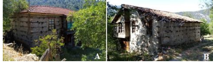
Fotoğraf 21. A. Kırma çatı örnekleri A.112A/17P, B. Beşik çatı örneği 112A/24P
