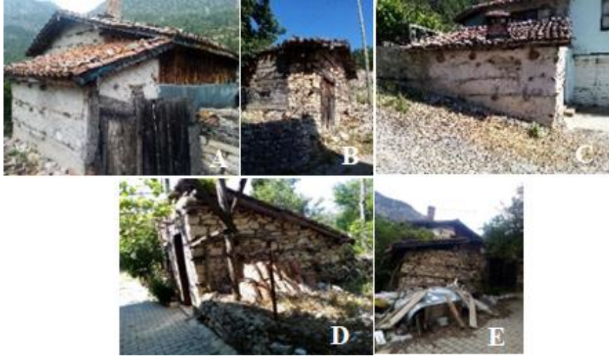
Fotoğraf 7. Avluda servis mekanları A.B.C.125A/10P, D.112A/8, E.125A/9P
