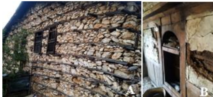
Fotoğraf 13. Konutların yapım sistemi A.121A/4P, B. Duvar sıva detayı 132A/3P
