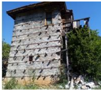
Fotoğraf 9. Zemin kat havalandırma penceresi 112A/17P
