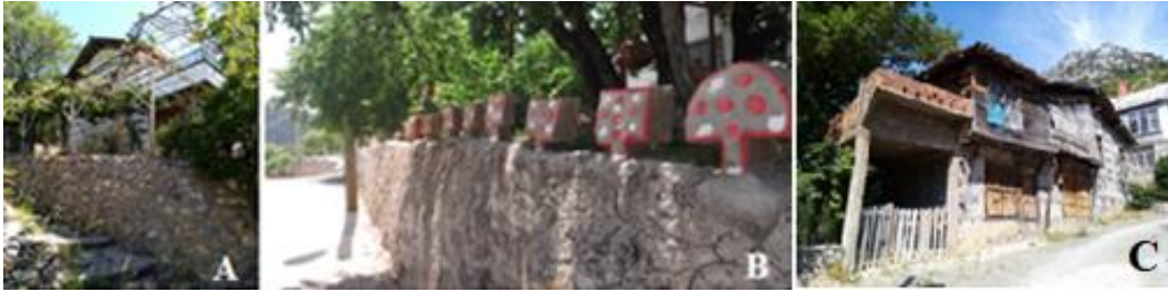
Fotoğraf 4. Avlu/bahçe duvarı A.116A/2P, B.120A/5P, C.108A/4P
