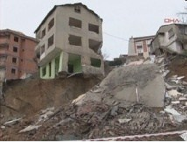
Şekil 31. İstanbul Gaziosmanpaşa'da yaşanan göçük olayı.
