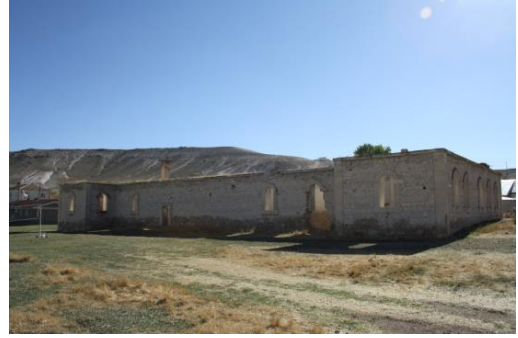
Fig. 3. Örenşehir İlkokulu giriş cephesi
