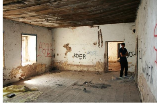
Fig. 30. Halitbeyören Köyü İlkokulu dersliği
