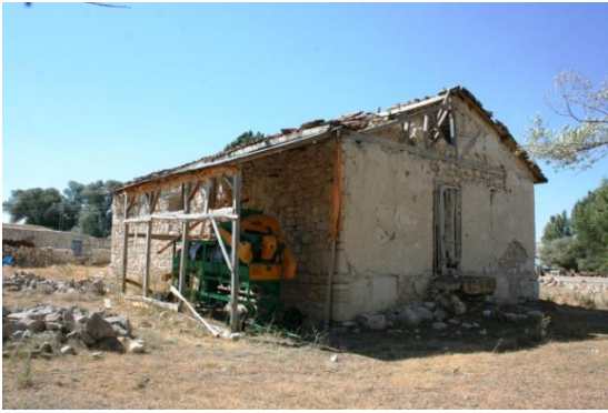
Fig. 19. Üçpınar Köyü İlkokulu giriş cephesi
