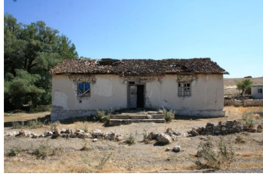
Fig. 18. Üçpınar Köyü İlkokulu giriş cephesi
