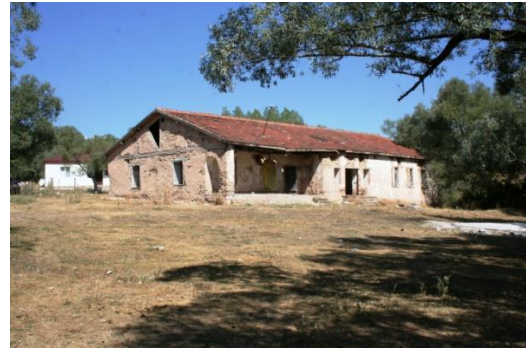
Fig. 29. Halitbeyören Köyü İlkokulu giriş cephesi
