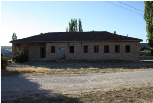
Fig. 22. Panlı Köyü İlkokulu giriş cephesi
