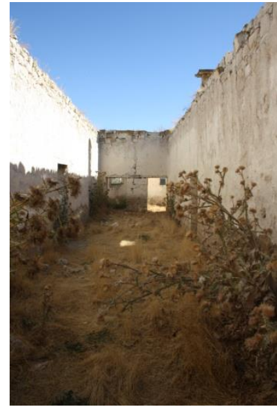
Fig. 4. Örenşehir İlkokulu giriş holü
