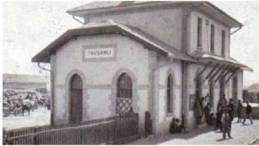
Fig. 4. Tavşanlı İstasyonu Eski Yolcu Binasının 1939 Tarihli Genel Görünüşü (Tavşanlı Belediyesi Fotoğraf Müzesi Arşivi).
