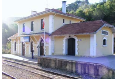
Fig. 16. Kütahya-Tavşanlı Hatı üzerinde Yer Alan Nusrat İstasyonu Yolcu Binası (Google).
