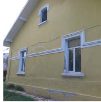
Fig. 20. Kütahya ve Afyon İstasyonları Lojman Binaları (16/10/2018).
