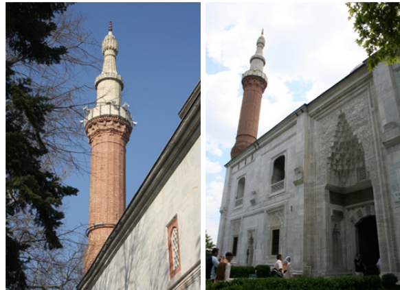
Fig. 6-7. Bursa Yeşil Cami Minareleri
