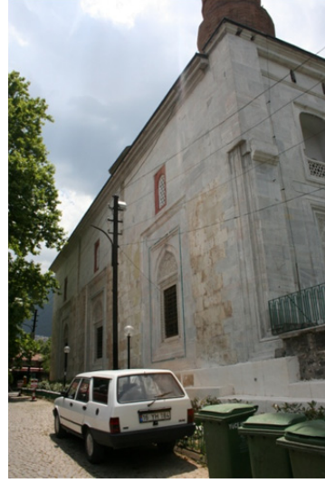
Fig. 18. Bursa Yeşil Cami Kuzey Cephesinde Tabhane Hücreleri ve Camiye Girişin Açıldığı Koridor ve Caminin Doğu Cephesi
