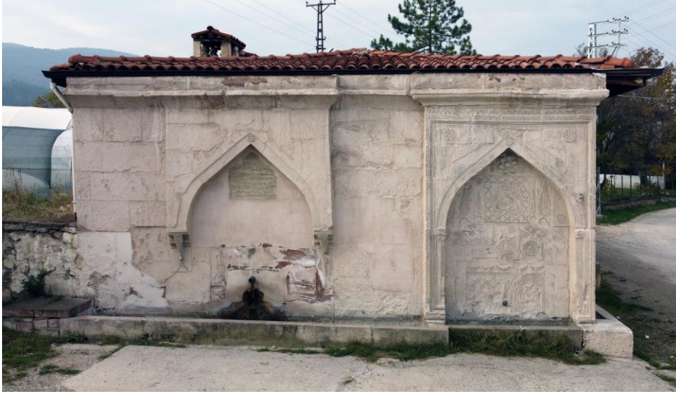
Foto. 5. Çeşmenin doğu duvarı
