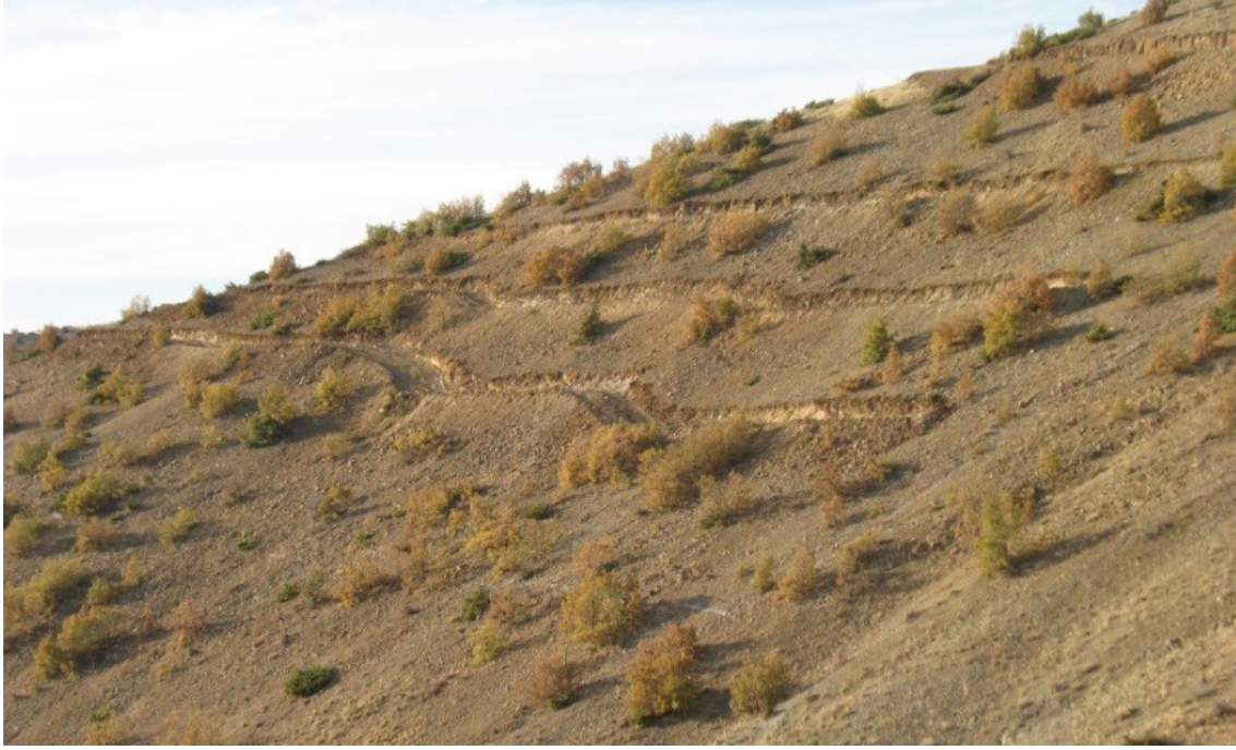
Şekil 3. En solda H1, ortada H2 ve sağda H3 düşey aralığında Baskil-Çavuşlu'da tesis edilen seki teraslar. Figure 3. A view of bench terraces established in Baskil (on the left H1, in the middle H2, on the right H3 vertical interval)
