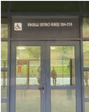
Şekil 7. Kocaeli Stadyumu Erişilebilir Giriş ve Çıkış Kapıları ve Rampalar
