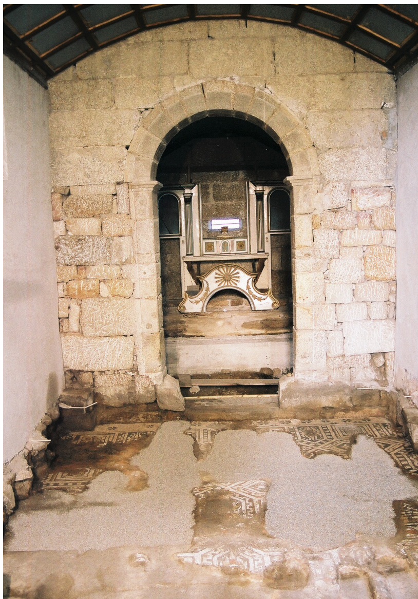
Figure 3 Panoramique de la nef et sanctuaire de l'église de Santa Maria do Freixo au final des fouilles
