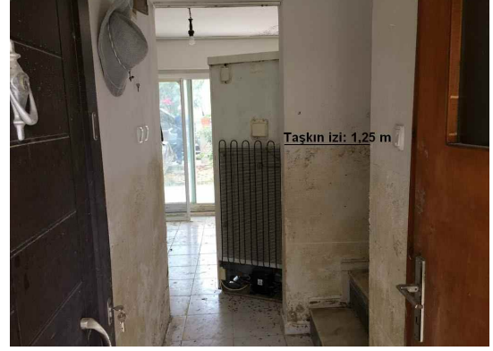
Fotoğraf 11. 21 Kasım 2016'da Ayvalık'ın Altınova Mahallesindeki Karakoç Deresi taşkınının evlerin alt katlarında hasara neden olan seviyesi (Ahmet Ertek arşivi, 22.5.2017).
