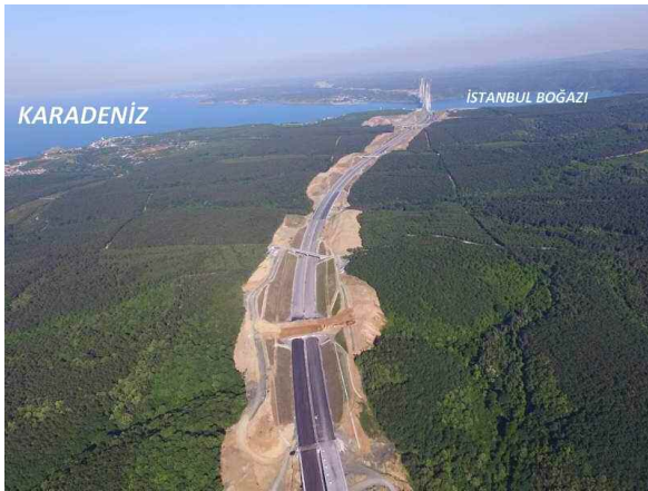
Fotoğraf 18. Kuzey Marmara Otoyolu ve İstanbul Boğazındaki III. asma köprü: Yavuz Sultan Selim Köprüsü dolayısıyla değişen peyzaj ( http://www.milliparklar.gov.tr ).
