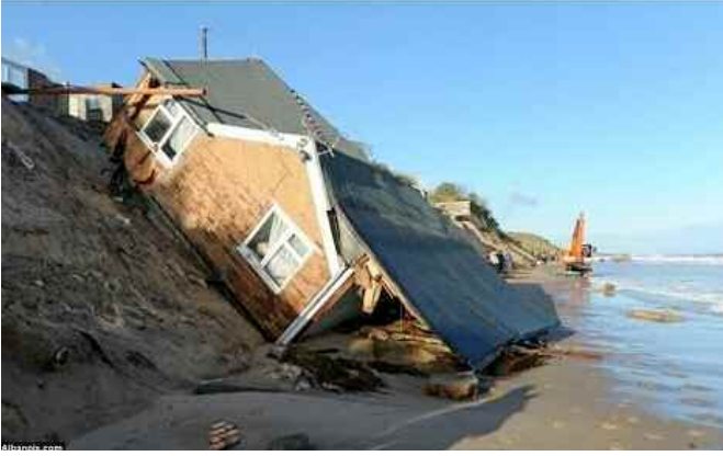
Fotoğraf 14. Yılda 20-30 cm gerileyen güneybatı İngiltere'de Porthleven'de 17.02.2014'te oluşan kıyı erozyonu ve yanlış arazi kullanımı (article.wn.com). Photo 14. Occurs on 17.02.2014 coastal erosion in southeast UK-Porthleven, declining 20-30 cm per year and wrong land-use.
