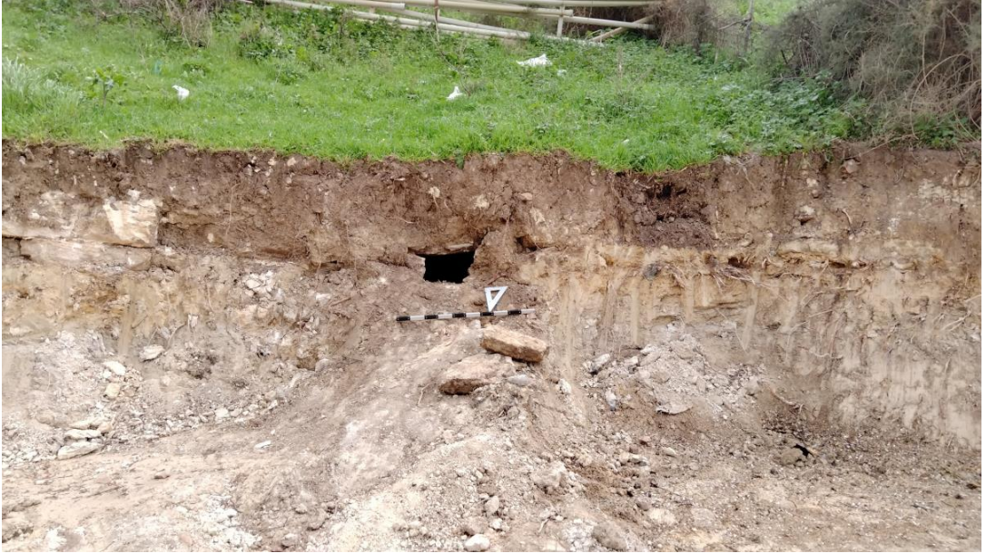
Resim 3: Çalışma sırasında açılan bu delik, su toplama tünelinin yamaçtan içeriye doğru açılan ağız üst kısmına denk gelmektedir.
