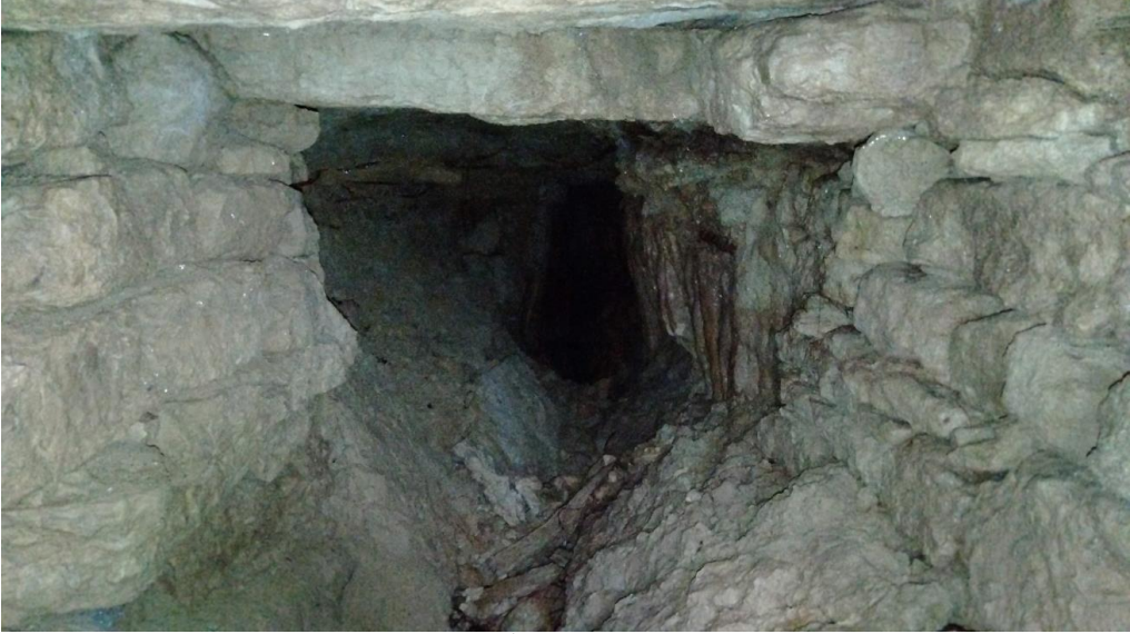
Resim 4: Tevfikiye kuzey eteğindeki “İki Kurnalı Çeşme”yi besleyen su tünelinin girişi. Bu yapay tünelin içeri doğru uzadığı açıkça görülmektedir.
