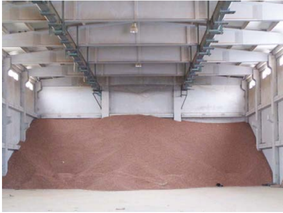
Şekil 2.3. Fındık depolamasında kullanılan bunker silo.
