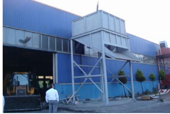
Şekil 2.6. Çelik bunker silo
