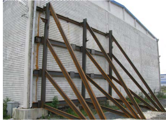
Şekil 4.2. Bunker sistem fındık silosunda yan duvar açılması
