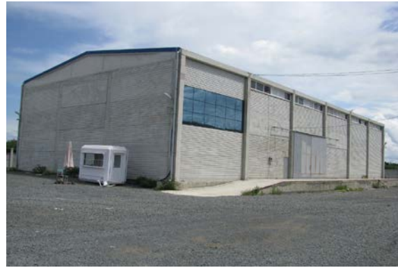
Şekil 2.7. Betonarme bunker silo
