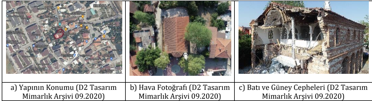
Şekil 1. Aya Yorgi Kilisesi Konumu ile Batı ve Güney Cepheleri
