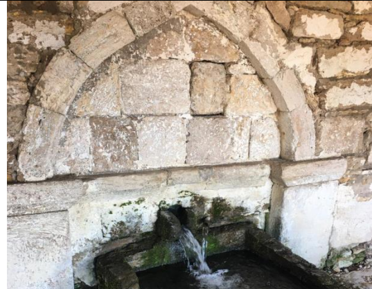
Foto 20. Akyaka Köyü Çeşmesi taş malzemeli lüle
