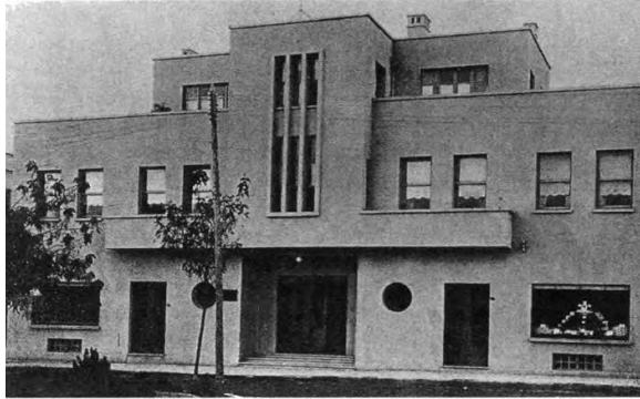
İnhisarlar Tekel İl Müdürlüğü Binası (S. Bozdoğan)
