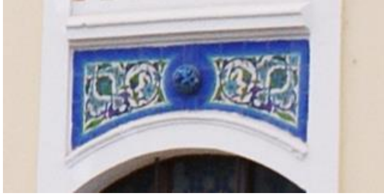
Konya Postane Binası Cephe Detayı
