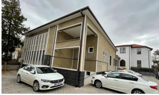
Fotoğraf 18. Yapının Güney Cephесinin Görünüşü
