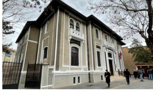
Fotoğraf 16. Yapının Kuzey Cephesi
