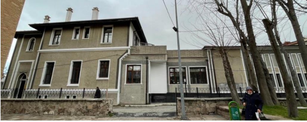
Fotoğraf 23. Yapının Batı Cephesinin Görünüşü
