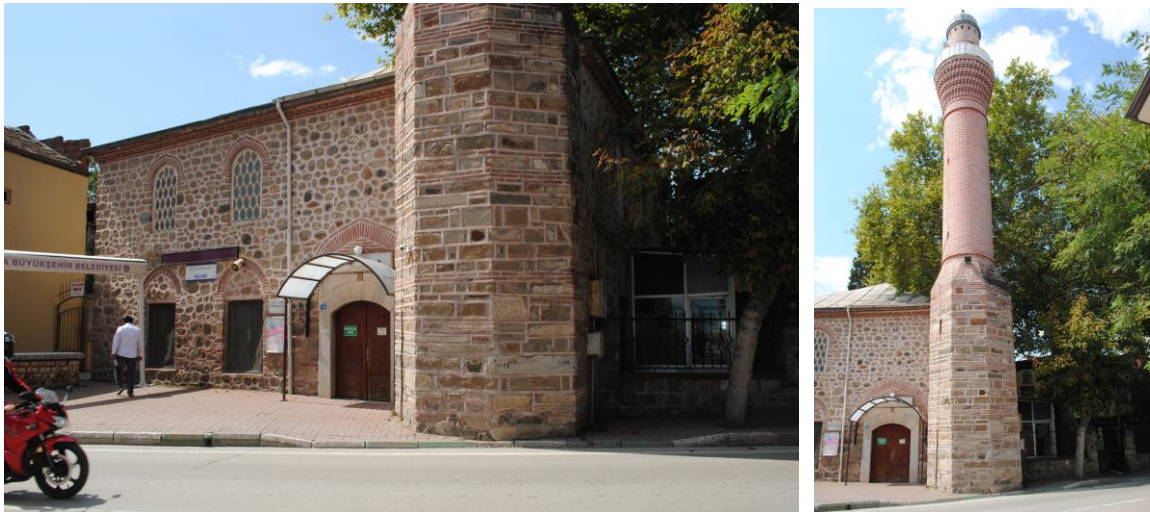
Fotoğraf 6-7: Mudanya Halil Ağa (Eski) Camisi doğu cephesi ve minaresi
