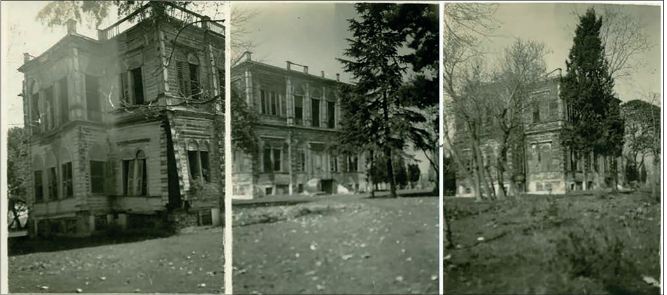
Fotoğraf 5. Yıkılmadan önce, V. Murad Av Köşkü / Murad V Hunting Lodge before its demolition (KVKKA).
