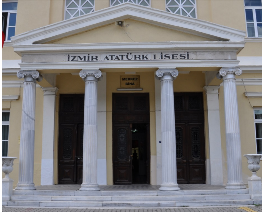
Şekil 46. İzmir Atatürk Lisesi, doğu cephe, ön giriş, doğudan görünüş
