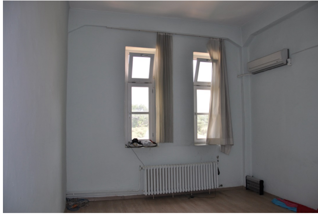
Şekil 41. Atatürk Lisesi, ikinci kat, güney bölüm, lojman, doğuya bakış
