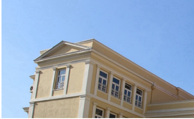
Şekil 58. İzmir Atatürk Lisesi, güney uçtaki bölüm, üçüncü kat, kuzeydoğudan görünüş
