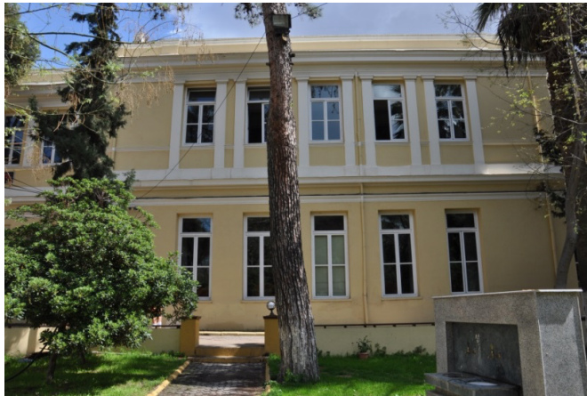
Şekil 61. İzmir Atatürk Lisesi, batı cephe, orta bölüm, batıdan görünüş
