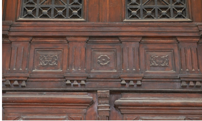
Şekil 67. İzmir Atatürk Lisesi, doğu cephe, ana giriş kapısı, üst bölüm, bezeme detayı
