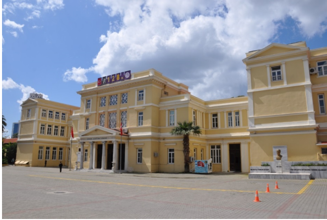
Şekil 44. İzmir Atatürk Lisesi, doğu cephe, kuzeydoğudan görünüş
