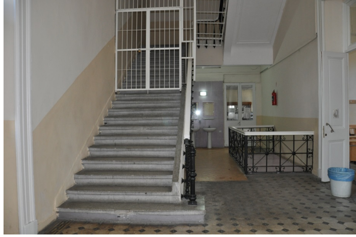
Şekil 16. Atatürk Lisesi, zemin kat, güney koridor, güney uç
