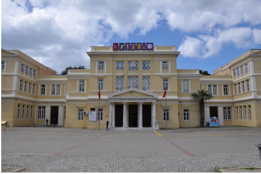
Şekil 45. İzmir Atatürk Lisesi, doğu cephe, doğudan görünüş
