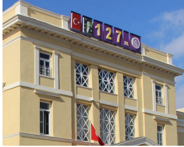
Şekil 52. İzmir Atatürk Lisesi, doğu cephe, orta bölüm, birinci ve ikinci kat, güneydoğudan görünüş
