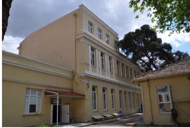
Şekil 60. İzmir Atatürk Lisesi, batı cephe, kuzey bölüm, kuzeybatıdan görünüş
