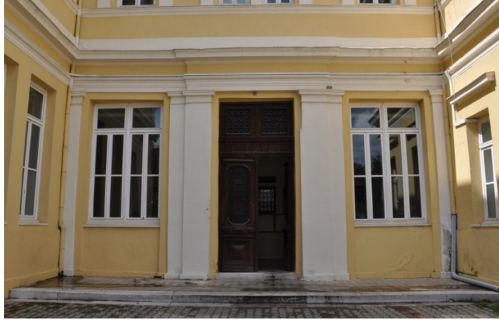
Şekil 50. İzmir Atatürk Lisesi, doğu cephe, güneydeki girintili bölüm, zemin kat, doğudan görünüş
