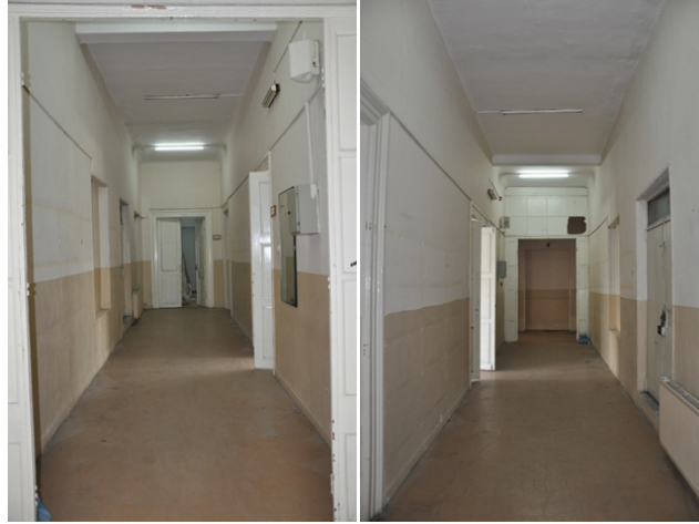
Şekil 33. Atatürk Lisesi, ikinci kat, orta bölüm, koridor, güneye ve kuzeye bakış
