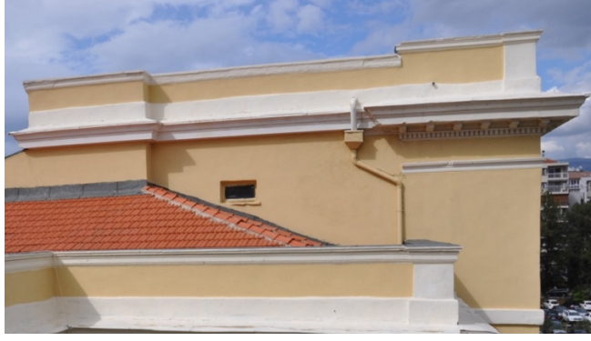
Şekil 57. İzmir Atatürk Lisesi, orta bölüm, üçüncü kat, güneyden görünüş
