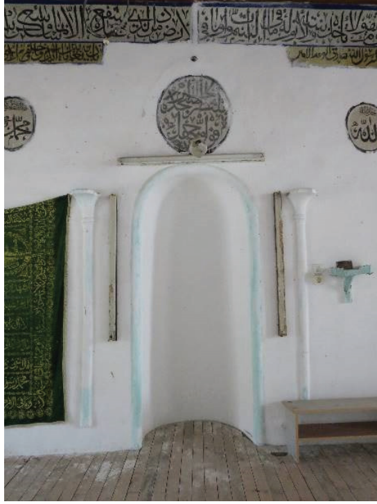
G. 21: Köylüce Köyü Eski Camisi Güney Cephe (S. E. Koçer, 2021)
