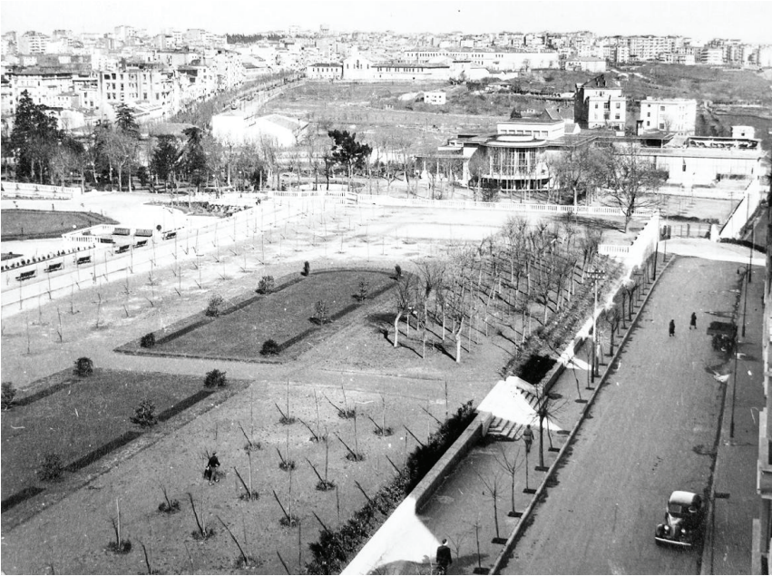
G. 3: Mete Caddesi'nden İnönü Gezisi, Taksim Bahçesi ve Belediye Gazinosu'nun görünümü, 1940'lar (Fonds Prost. Académie d'architecture/Cité de l'architecture et du patrimoine/Archives d'architecture contemporaine, HP-PHO-027-01-33)
