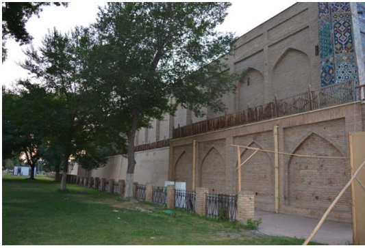
Fotoğraf 4: Güney cephe görünümü.
