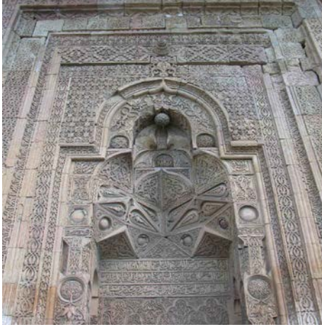
Resim 1. Divriği Ulu Camii, batı taç kapı.
