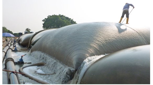
Şekil 16. Jeotekstil filtre ile susuzlandırma işlemi
