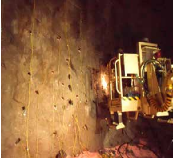
Şekil-7. Normet charmec ayna dolumu
