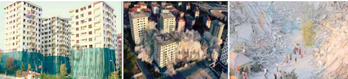
Şekil 16. Yıkım Öncesinde ve Yıkım Anında Binaların Görüntüsü
