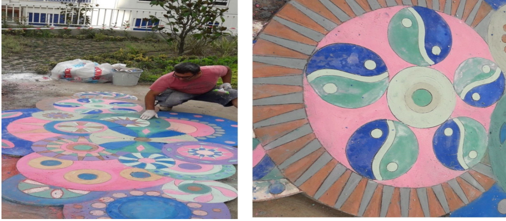
Görsel 12. Harç tertibatının içerisindeki su ve nem miktarının fazla olması nedeni ile uygulamadaki renk oluşumları ve netlikleri ilk günlerde pastel tonda görülmektedir.
