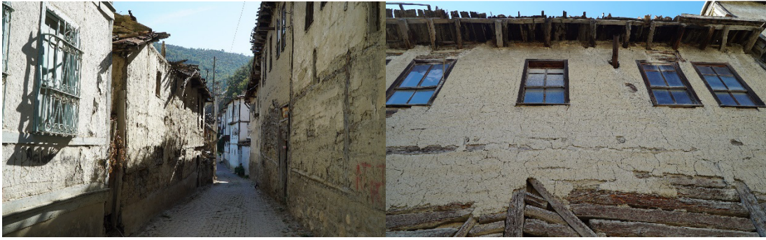
Şekil 16. Yapı dış çehresinde yetersiz saçak boyutundan dolayı dış etkenlerin neden olduğu bozulmalar
