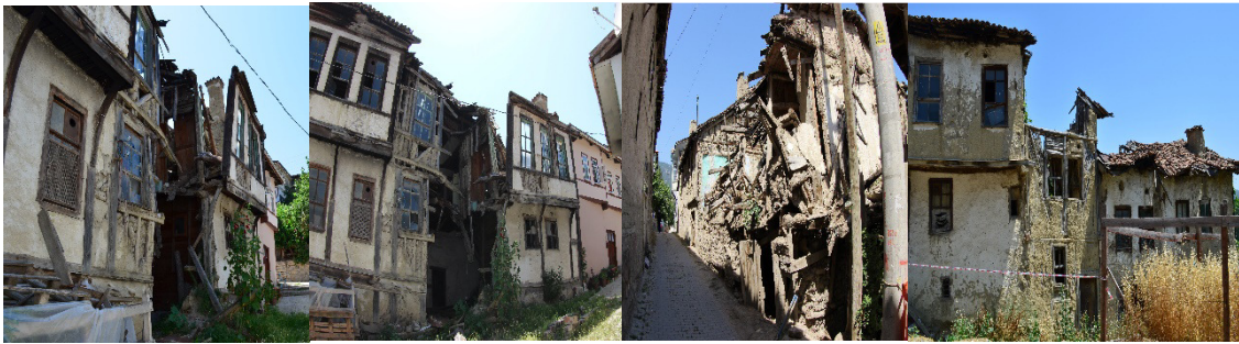
Şekil 13. Ahşap yapı elemanında zamana bağlı deformasyondan dolayı oluşan çökme
