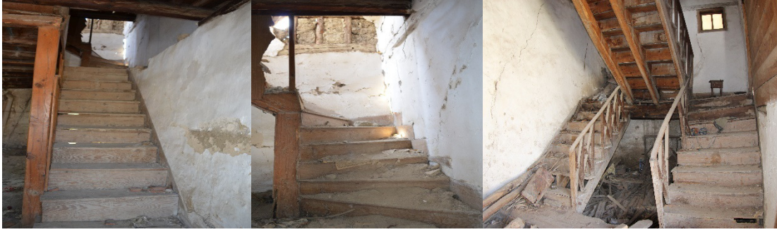
Şekil 12. Zemin kattan hayata çıkan merdiven
