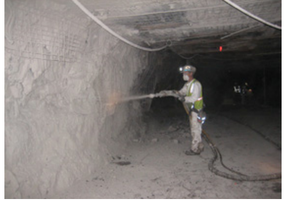
Şekil 1. PİK'in arazide uygulanması (www.meyco.basf.com)
