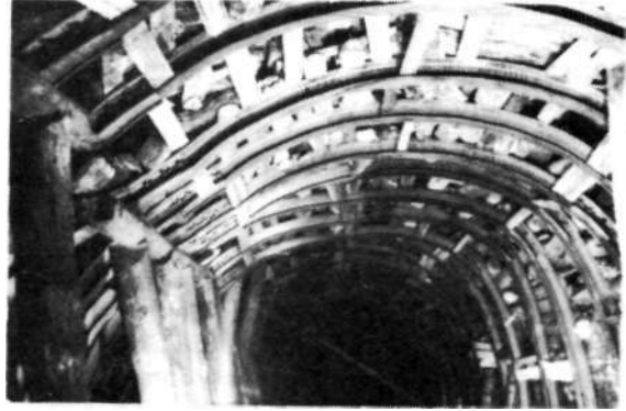
Şekil 8. Taban yolunda kavisli bağ denemesi.
