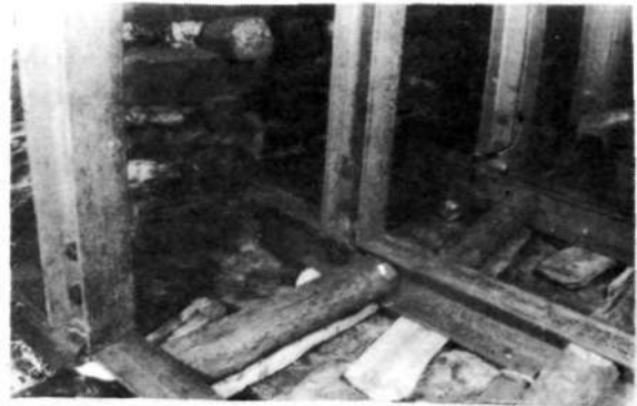
Şekil 11. Kayıcı bağda boyunduruk-direk bağlantısı.
