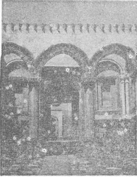
Resim 23: İshak Paşa Sarayı'nda Harem Bölümündeki "Taşlık"ın görünüşü.
