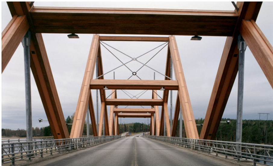
Şekil 1. Mikko Junninen, Vihantasalmi köprüsü.
