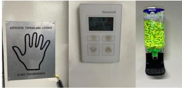
Şekil 7. Deşarj Levhası, Termal kontrol paneli (Çalışma Ortamı Isı kontrolü) ve Yüksek Ses ve gürültü için kulan tıkaçı
