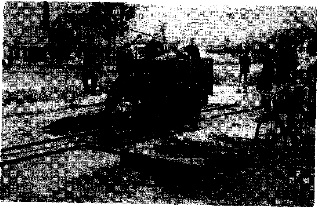
Resim 1 İstanbul Aftumizâde'de Prototip Grahby araba ile rampanın denenmesi. Kasayı yukarı kaldıracak olan topuzla kol açık dununda ve rampaya yanaşmak üzere. Arabayı çeken zincir kamyonu bağluda*.
