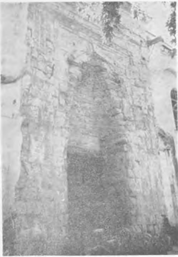
Resim: 1 — Bursa Ulu Câmi tak kapısı.
