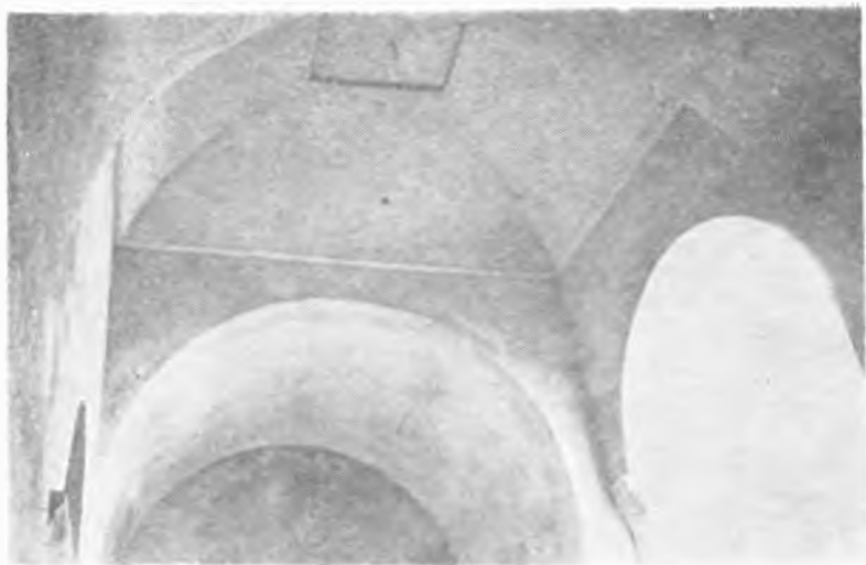
Resim: 7 — Son cemaat yerinin örtü sistemi (1976)
