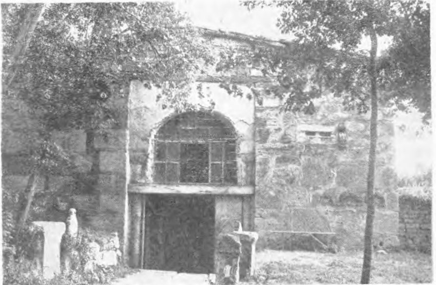
Resim: 4 — Koçaş Camiinin giriş cephesi (1969 daki durumu).
