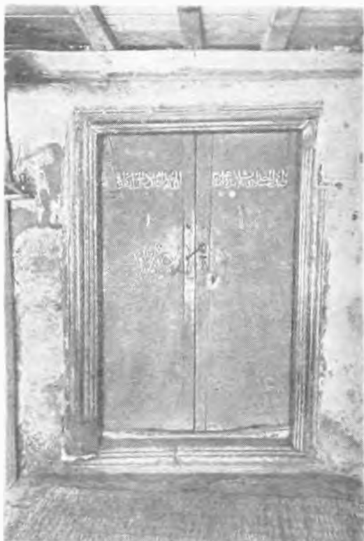
Resim: 8 — Caminin iç kapısı ve son cemaat yerindeki ahşap tavan (1969).
