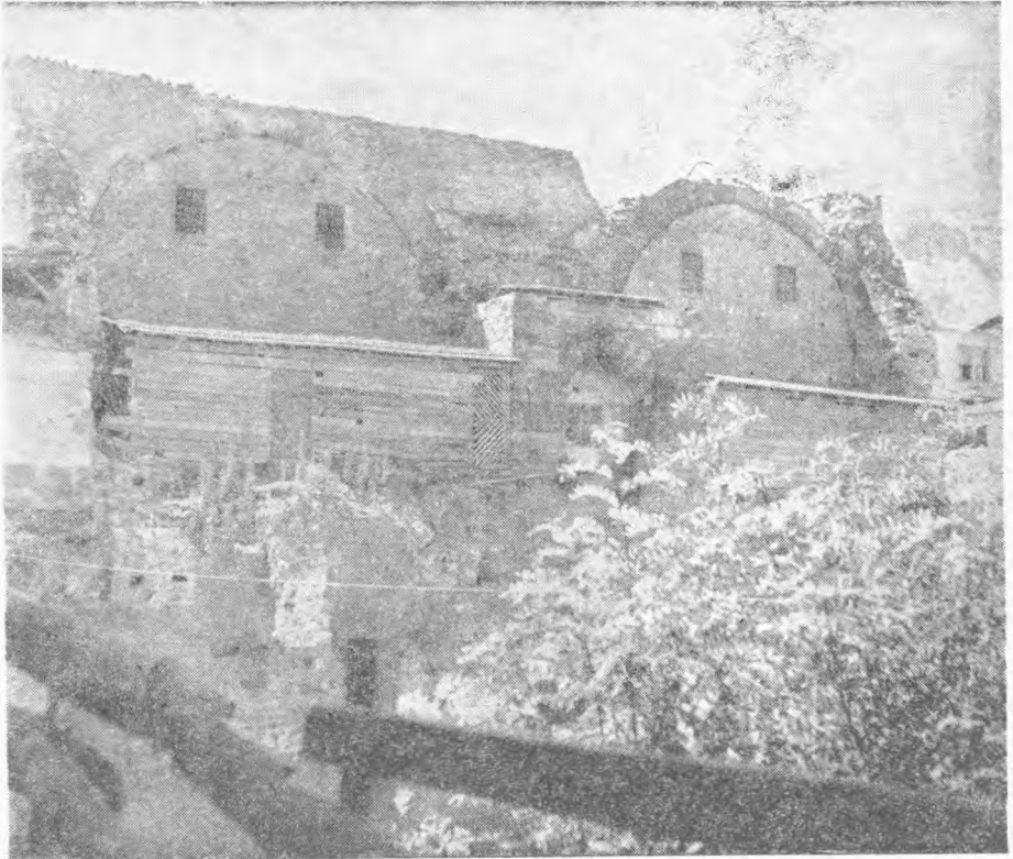
Resim: 8 — Amasya bedesteninin yıkılan ırmak tarafındaki bölümleri. Önde bu bölümlerin yerine yapılan işhanının temel kazısı.
