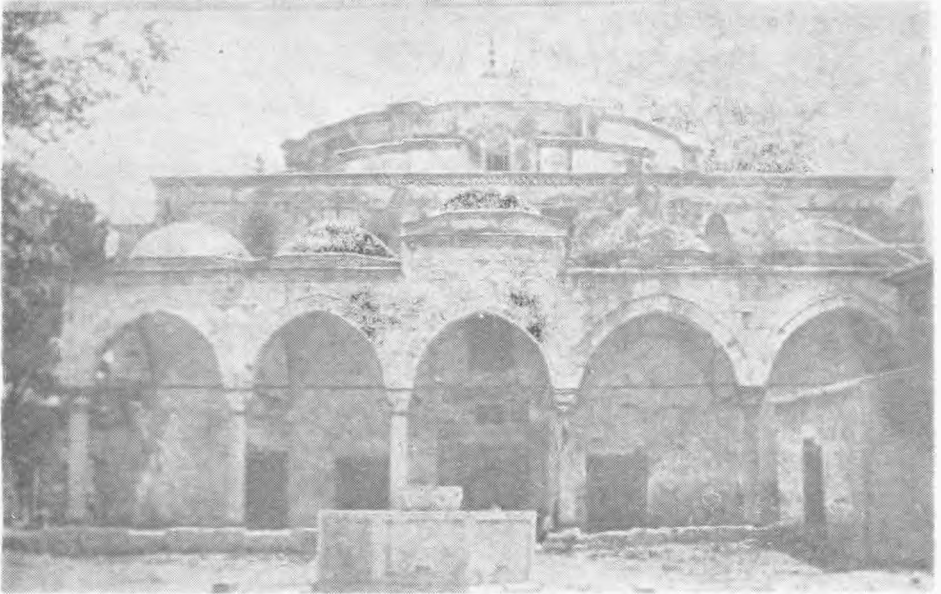
Resim: 35 — Küçük Ayasofya camii ve şadırvanı 1938'de (Tarafımızdan çekilmiştir).
