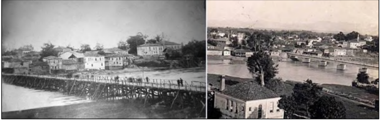
Resim 2. (a) Ahşap Çarşamba Köprüsü (b) Betonarme Çarşamba Köprüsü
