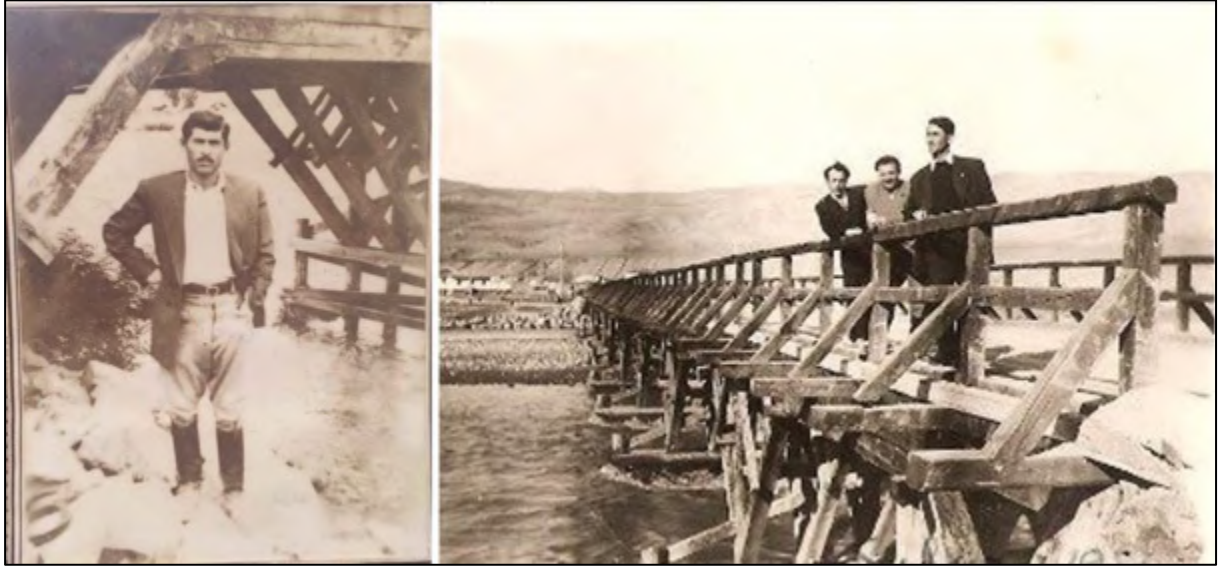
Resim 3. (a) Yemişan (Taşova) Köprüsü (b) Yemişan (Taşova) Köprüsü
