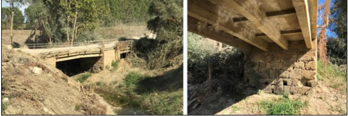
Resim 6. Kula Deresi ile Atatürk Caddesi kesişiminde bulunan köprü. Payanda yuvaları, köprüün özgün hali hakkında fikir vermektedir
