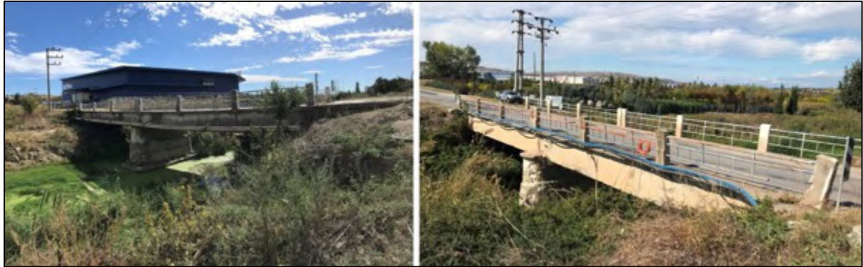
Resim 10. (a) Kula Deresi Köprüsü Memba Cephesi. (b) Kula Deresi Köprüsü Mansap Cephesi
