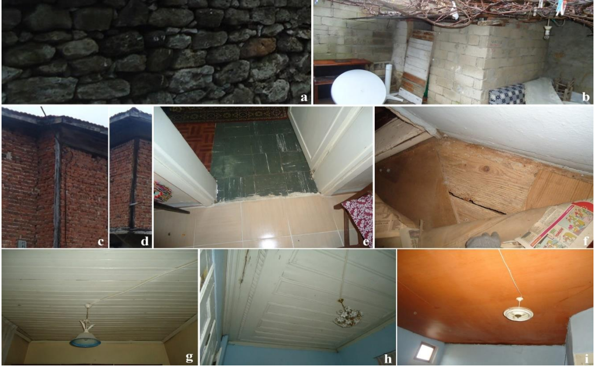
Foto 2. Yapı malzeme ve detay görüntüleri (a) moloz taş duvar, (b) briket duvar, (c) harman tuğla duvar, (d) köşe
