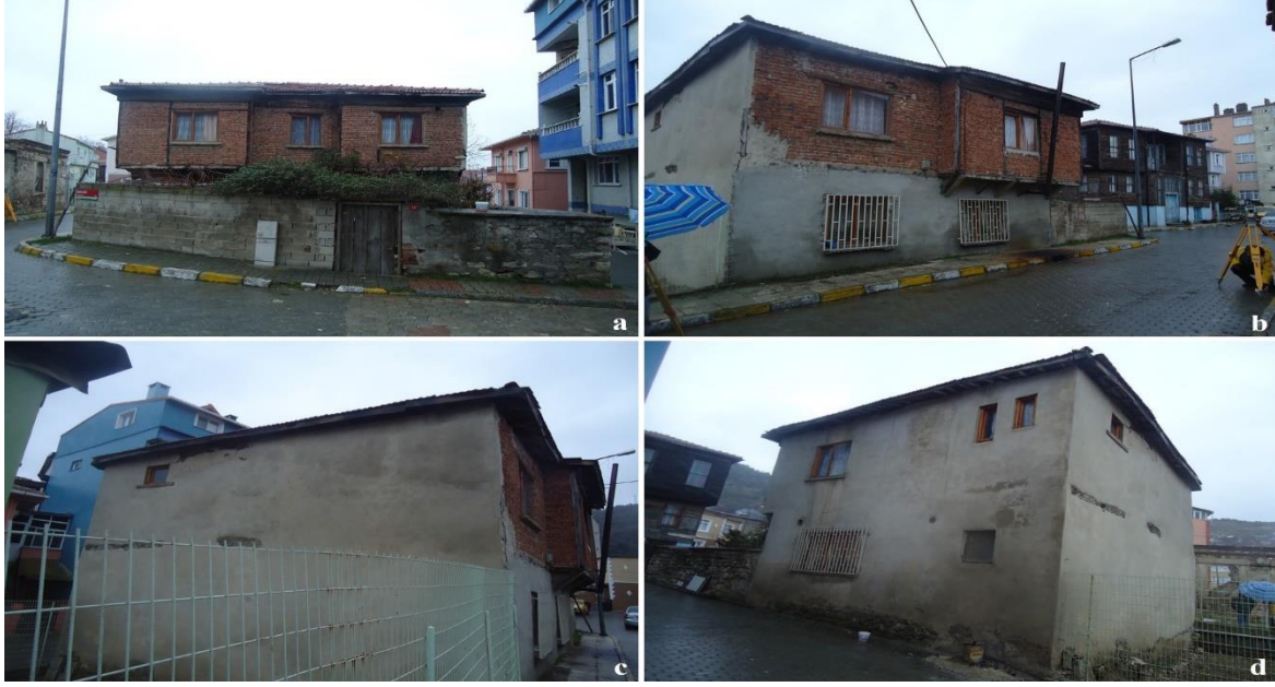
Foto 1. Yapı cephe görünümüleri (a) güney cephe, b) batı cephe, c) kuzey cephe, d) doğu cephe)
