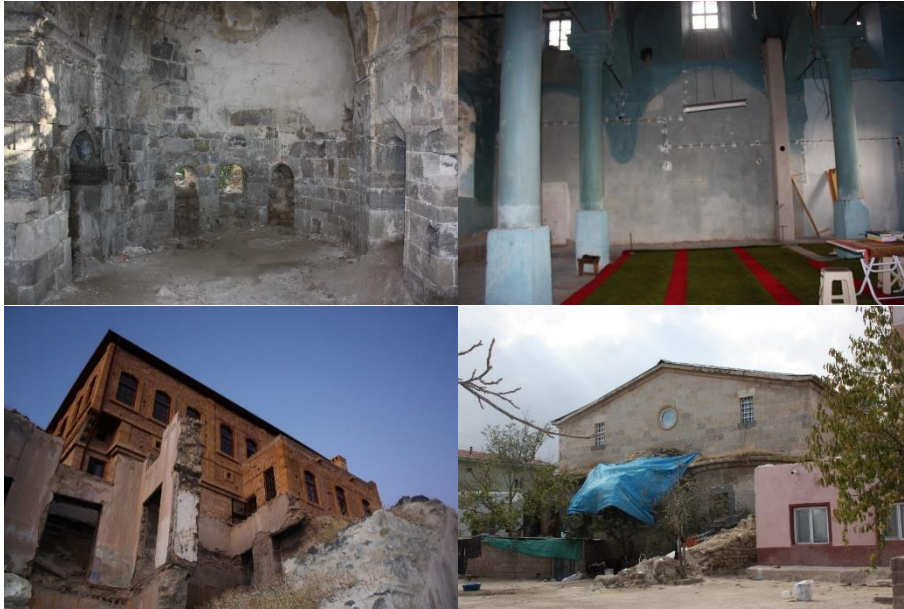
Şekil 22. Bozulmalara Neden Olan Etkenlere Örnekler, Bakımsızlık, Kapatılmış Açıklıklar, Yanlış Restorasyon, Muhdes-Nitelsiz Ekler [27]
