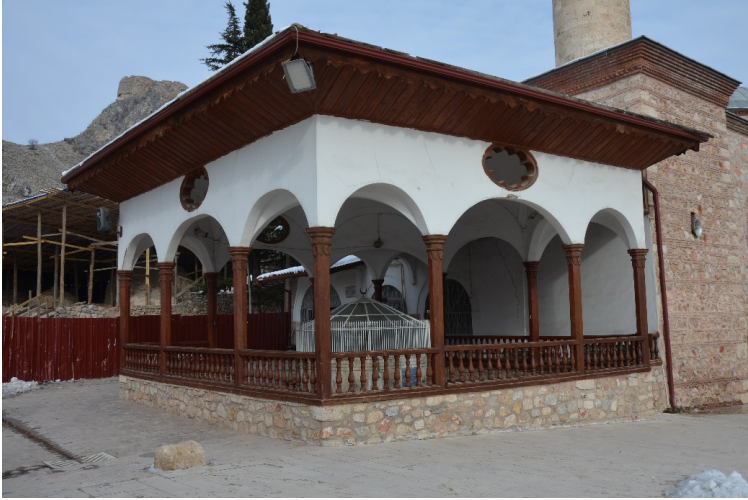
Şekil 11. Takyeciler Camii Şadırvanı Genel Görünüm
