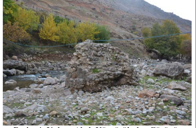
Resim 4: Yukarı Ahç Köprüsü'nden Görünüş
