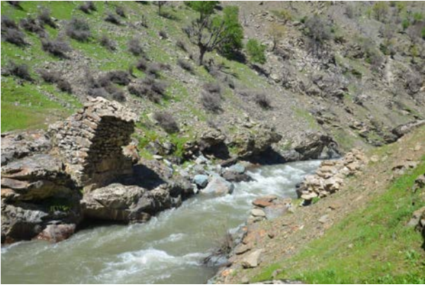
Resim 5: Deliktaş Köprüsü Kuzeyden Görünüş
