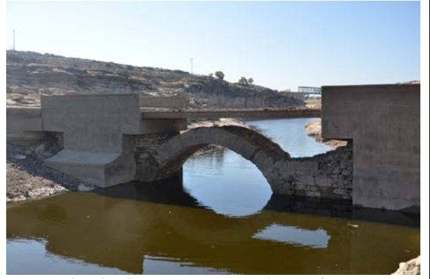
Resim 6: Pira Kurt Köprüsü'nden Görünüş
