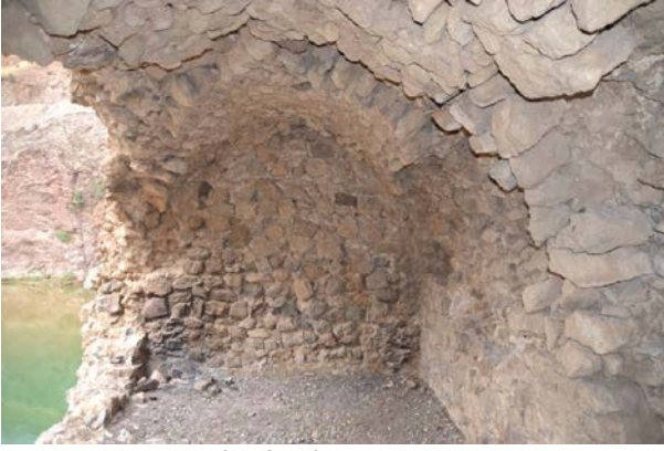
Resim 3: Pisyar Köprüsü Tonozlu Mekândan Görünüşü
