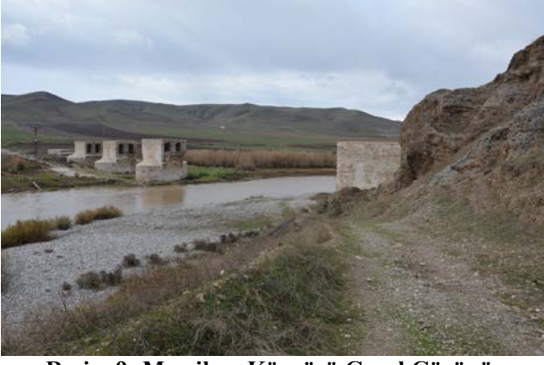
Resim 9: Memikan Köprüsü Genel Görünüş
