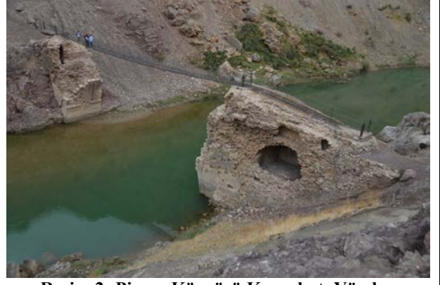
Resim 2: Pisyar Köprüsü Kuzeybatı Yönden Görünüşü
