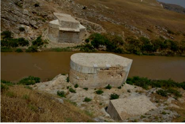
Resim 13: Şeyhosel Köprüsü, Kuzeyden Görünüş
