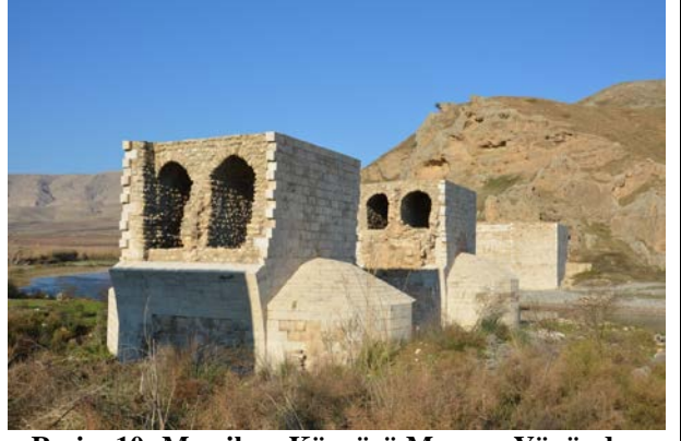
Resim 10: Memikan Köprüsü Mansap Yönünden Görünüş
