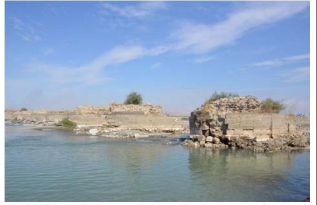
Resim 8: Pepira Köprüsü Ayakları Batıdan Görünüş
