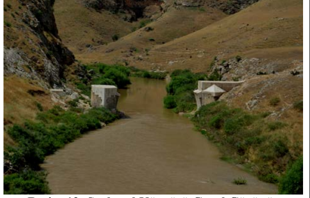
Resim 12: Şeyhosel Köprüsü Genel Görünüş
