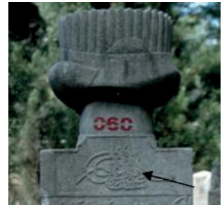
Görsel 80: Osmanlı Tuğrası süslemesinden görünüş.
